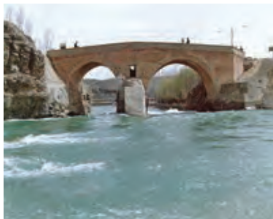
تصویر ۵۶- پل زمان خان - شهرکرد یا آب بند شوشتر
