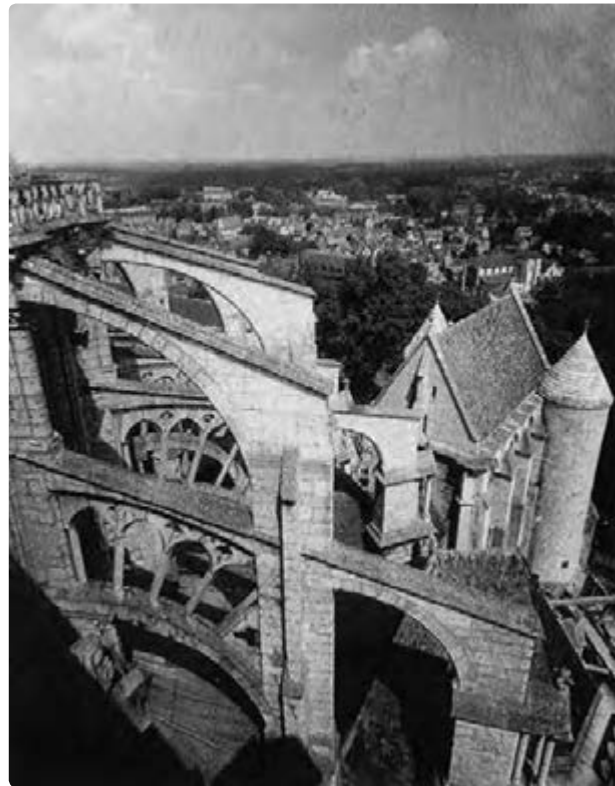
تصویر ۳۴- حایل‌های توخالی دیوارها در معماری گوتیک
