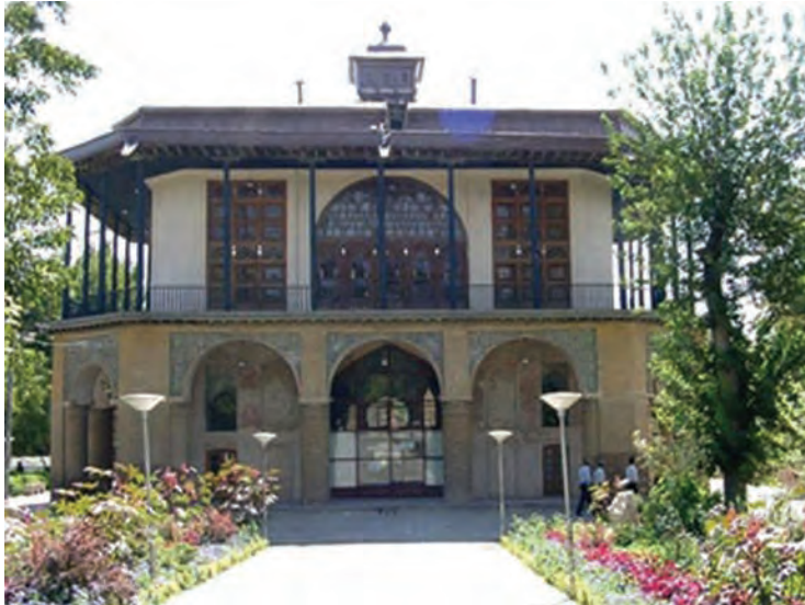
▲ شکل ۸-۱۲- عمارت چهلستون، قزوین
