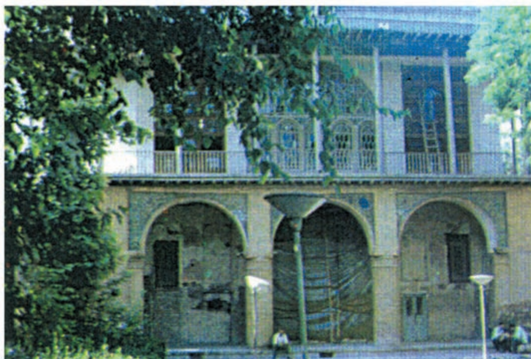
شکل ۱۲۱- عمارت چهلستون قزوین
