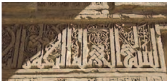
شکل ۶۲-۲- خراسان، آجر تراش، رباط شرف
