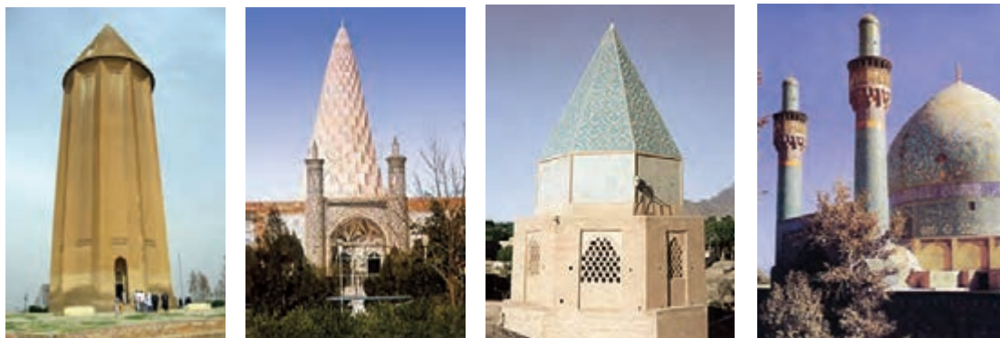
شکل ۱۶۳- گنبد نار مدرسه شکل ۱۶۴- گنبد رک هرمی شکل ۱۶۵- گنبد رک اورچین شکل ۱۶۶- مقبره رک مخروطی مقبره حاج عبد الصمد در نطنز در مقبره دانیال نبی در مقبره قابوس بن وشمگیر چهارباغ اصفهان
