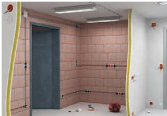
شکل ۳-۳۳- سیم‌کشی توکار
