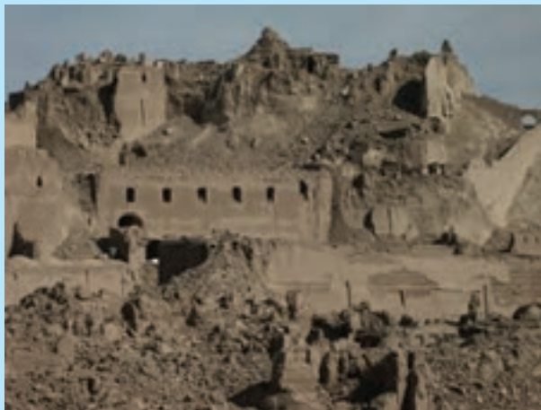
تأثیر زلزله دی‌ماه سال ۸۲ بم بر بناهای کهن و جدید شهر تصویر پایین ارگ تاریخی بم بزرگ‌ترین بنای خشتی جهان و تصویر بالا ساختمانی جدید با اسکلت فلزی
