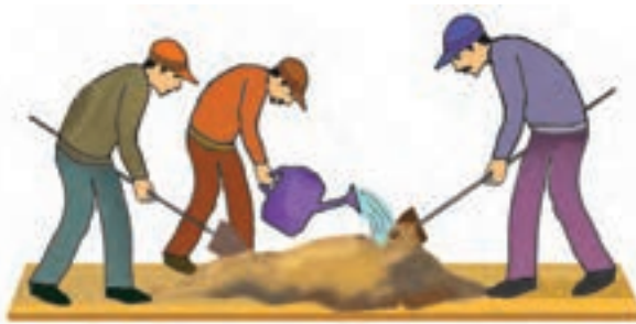
شکل ۳-۷- سرن‌کردن ماسه و مخلوط کردن ملات
