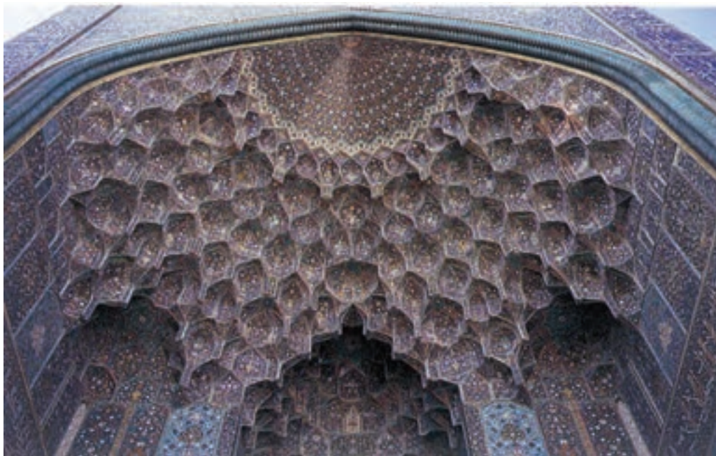
شکل ۱-۵۵ تزیینات معماری منقوش (مقرنس)، دوره‌ی اسلامی، سده‌ی دهم هجری قمری، نقوش اسلیمی ختایی در زمینه گره‌های برجسته
